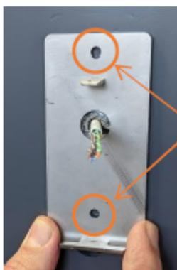
Passez le câble par le trou central, puis fixez la platine sur son support, à travers les deux trous de fixation.
